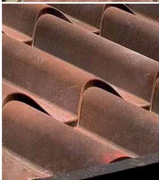
Dettaglio della copertura
